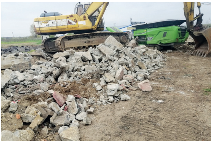
A betonhulladék aprítása után a településen kerül felhasználásra, utak, parkolók kialakítására, javítására.
