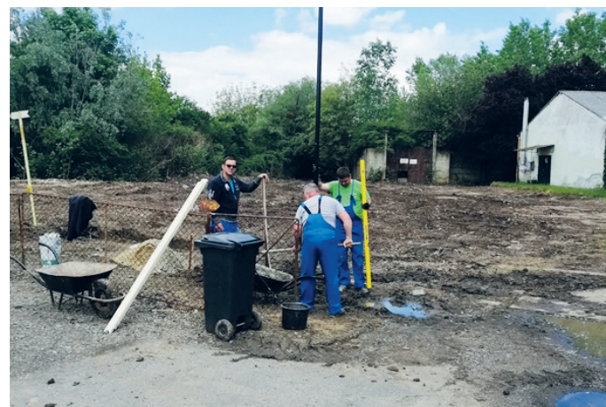
Kerítés készül a lakóterülettel határos oldalon, az illegális hulladék lerakásának megakadályozására.
